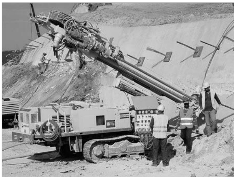
Рис. 4.7. Передвижная установка на гусеничном ходу для устройства буроинъекционных свай «ATLAS»
